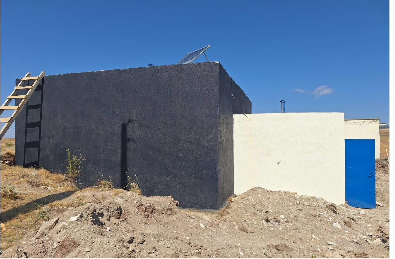
Alaca İlçesi Sarısüleyman Köyü-100 m3 Depo
