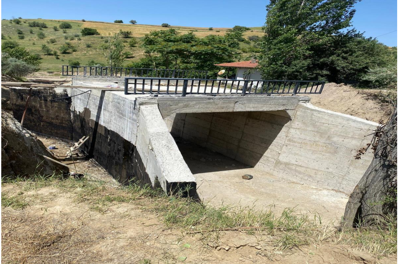
Bayat Beydili Köyü Menfez Yapımı
