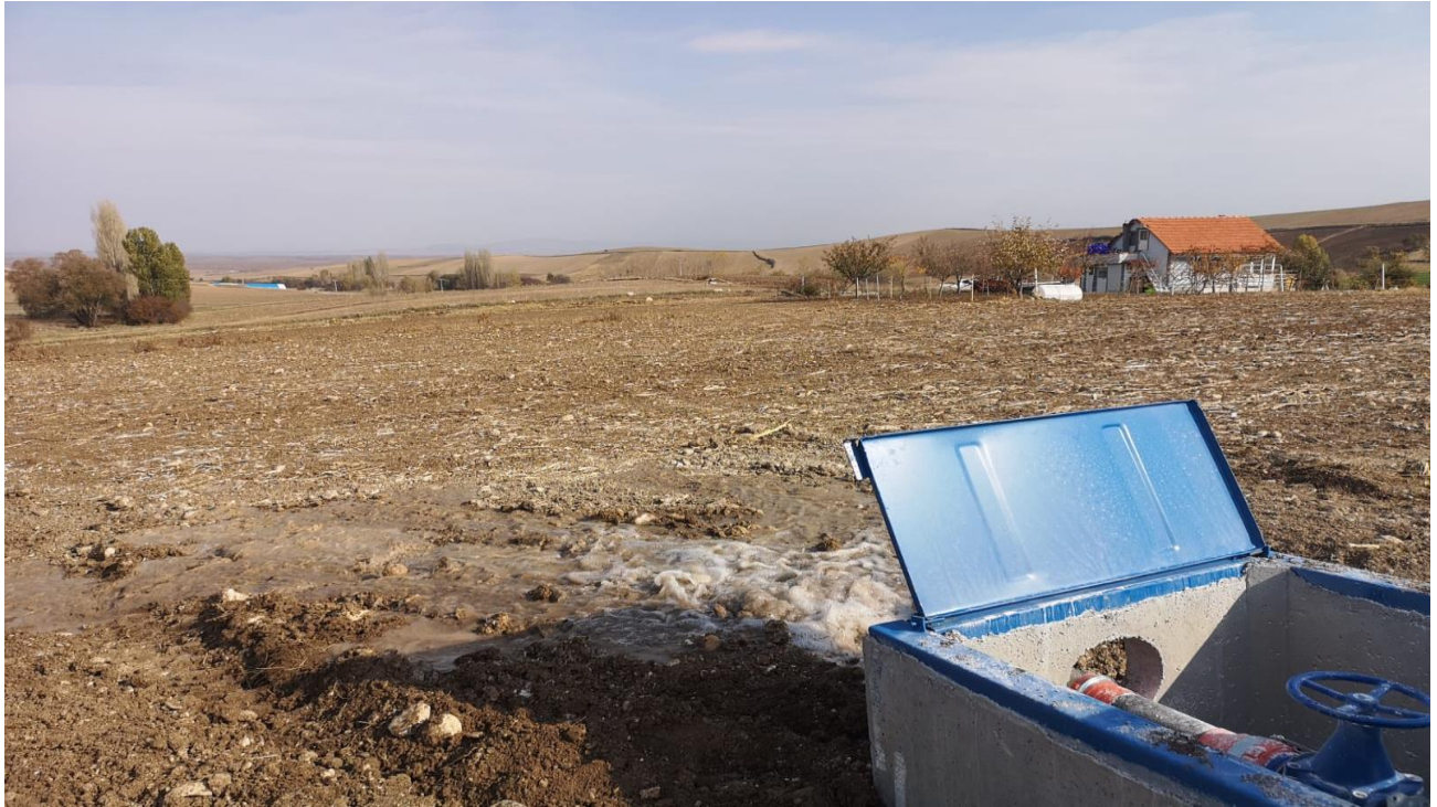
Alaca Kalecikkaya Mevcut Göletten Yağmurlama Sulama Tesisi Tamamlama
