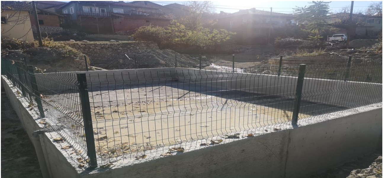
Mecitözü İbek Köyü Sulama Havuzu
