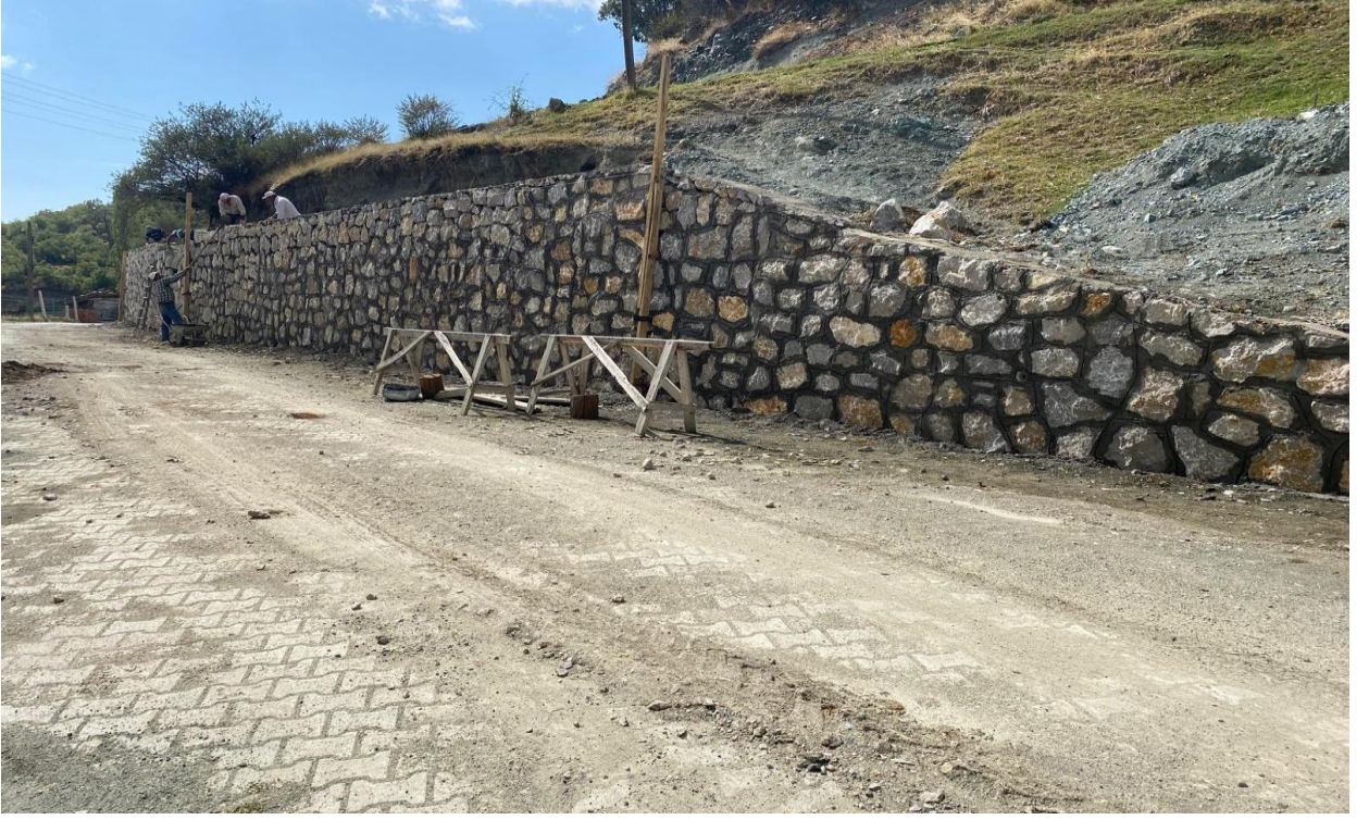
Bayat Çerkeş Köyü Taş Duvar Yapımı
