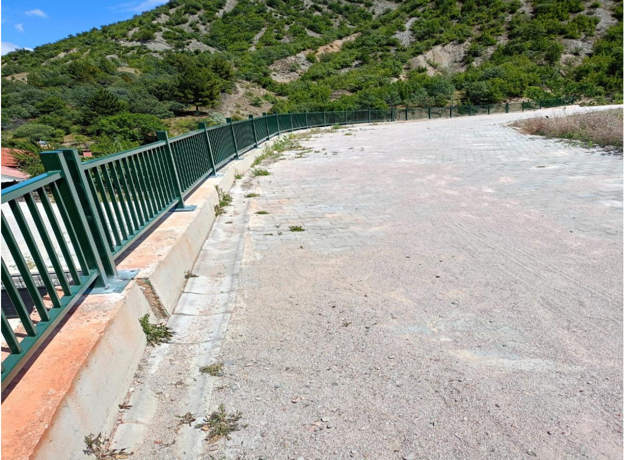
Osmancık Hanefi Köyü Korkuluk Yapımı
