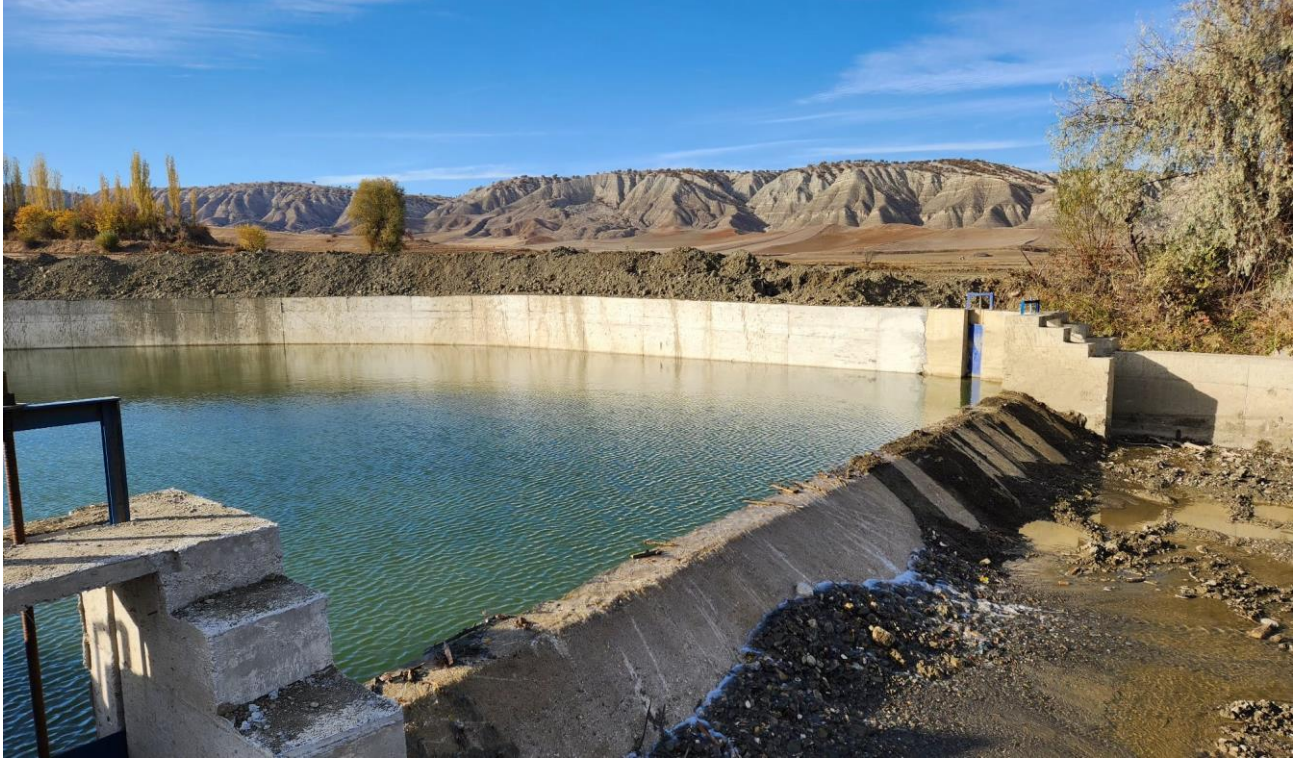
Merkez Şahinkaya Bent ve Kanal Onarım
