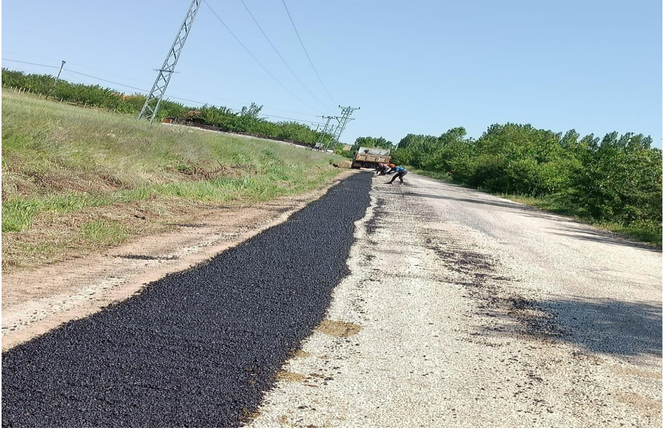
Asfalt Yol Bakım ve Onarımı (Yama) Çalışması
