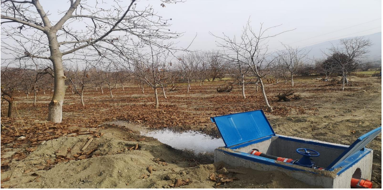
Mecitözü Emirbağ Mevcut Havuzdan Yağmurlama Damla Sulama Tesisi
