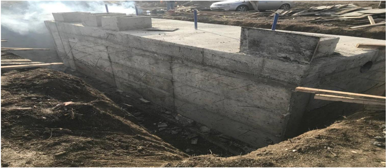
Bayat İlçesi Aşağıemirhalil Köyü 250 Kişilik Fosseptik İnşaatı
