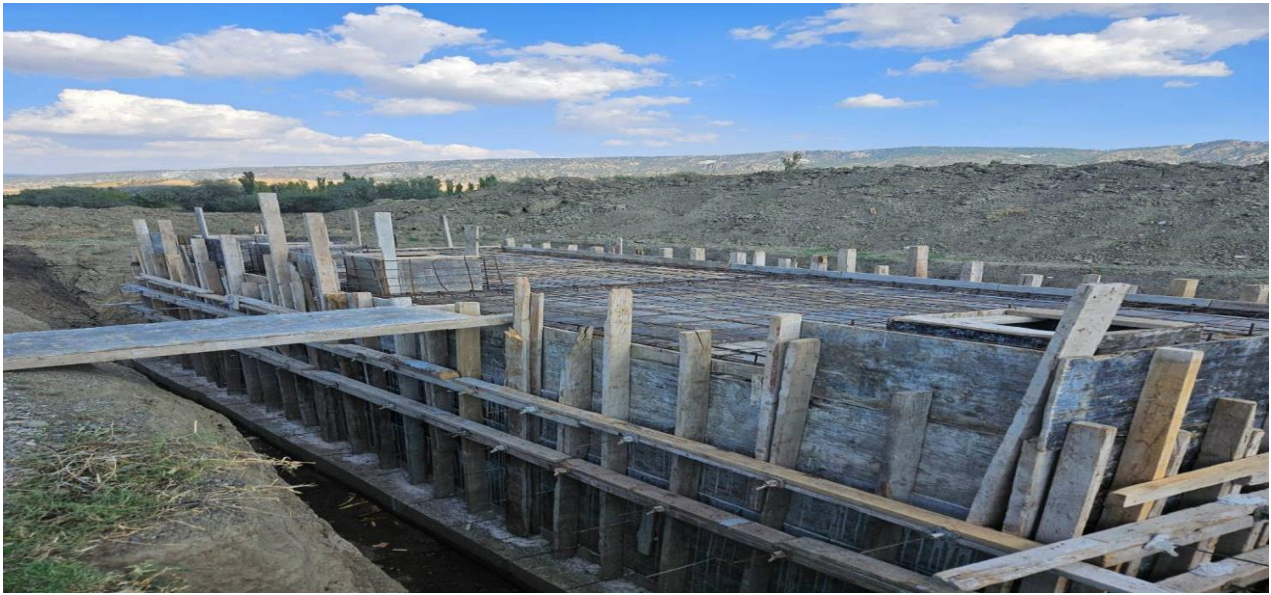
Uğurludağ İlçesi Sazköy Köyü 250 Kişilik Fosseptik İnşaatı
