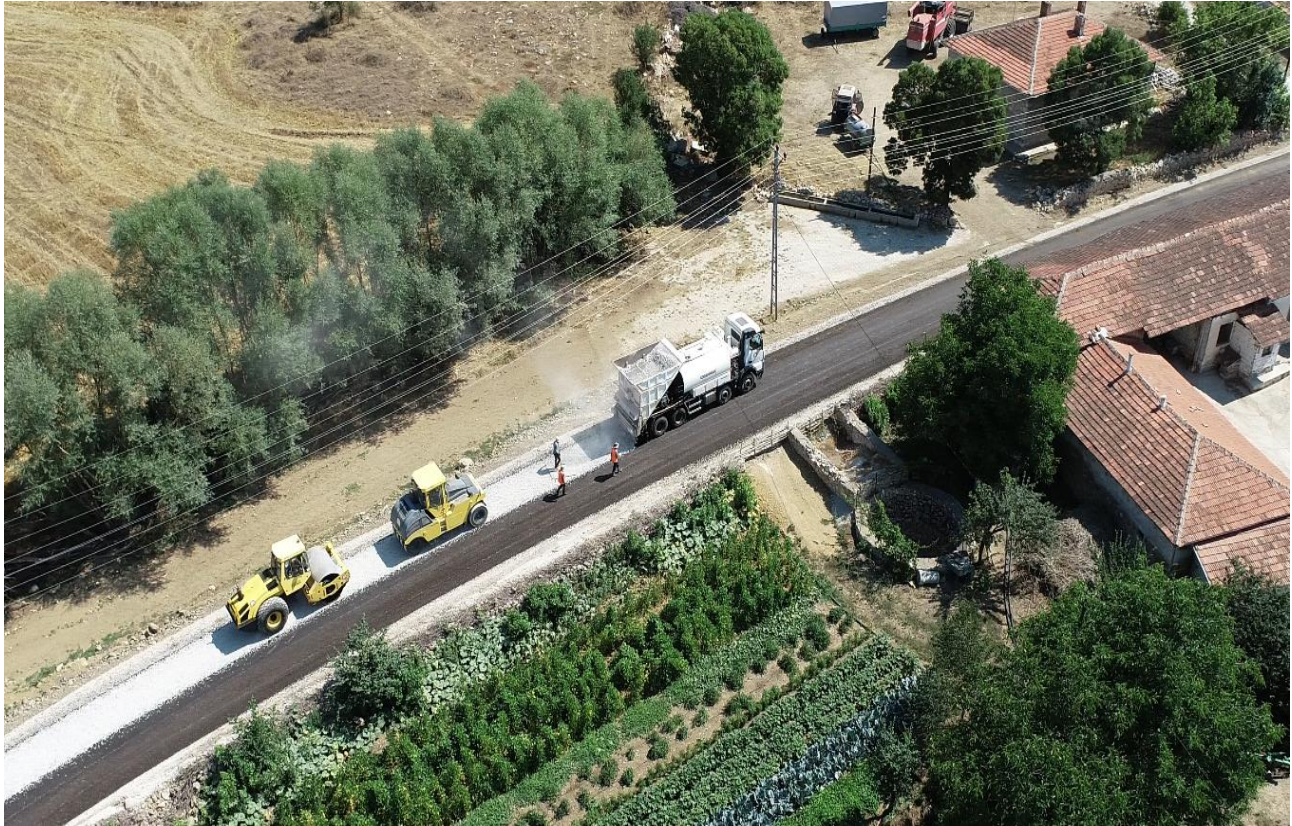
Merkez Karaağaç Palabıyık Grup Yolu 1. Kat Asfalt Sathi Kaplama
