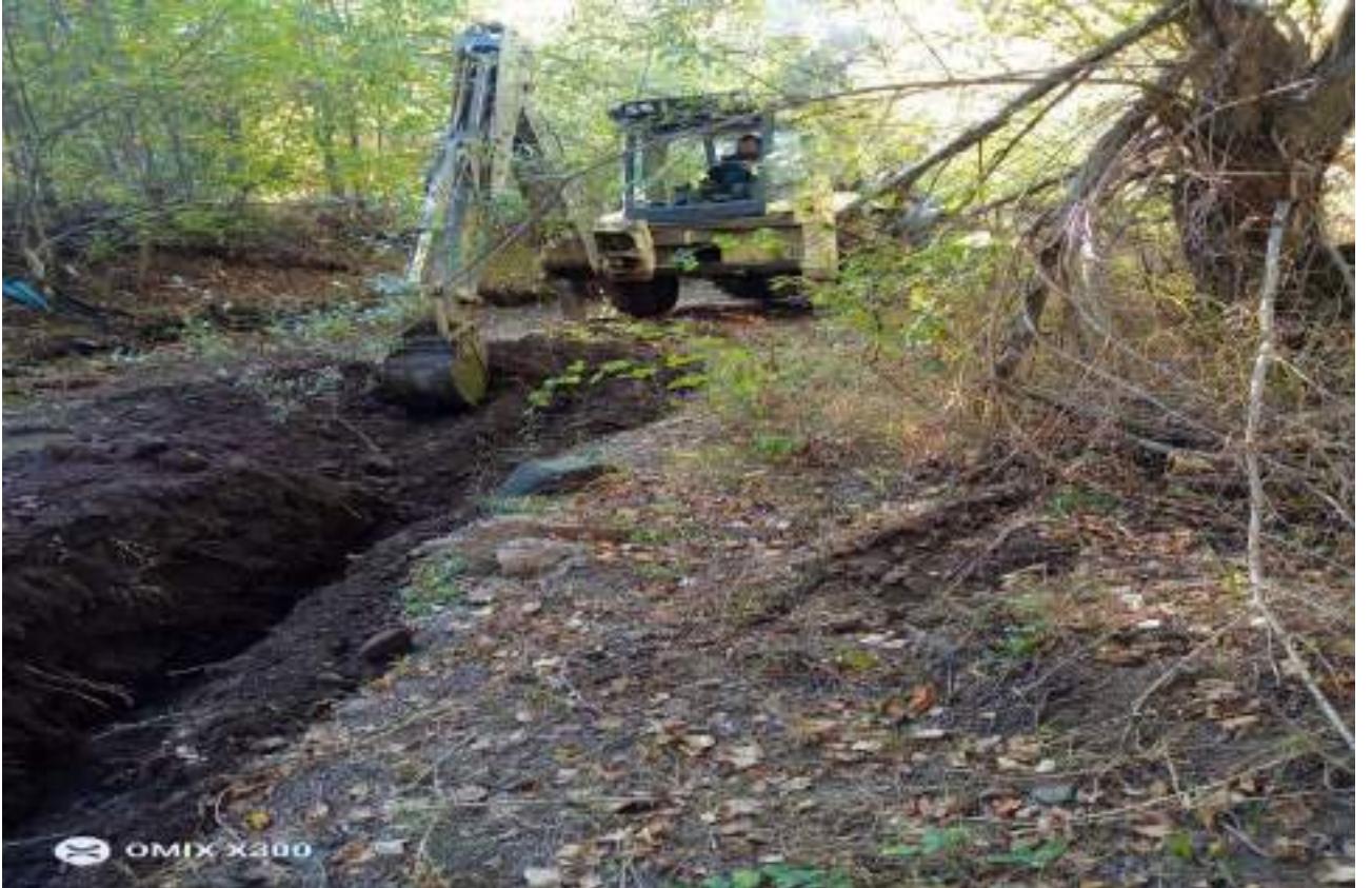
BAYAT İLÇESİ SARAY KÖYÜ KANALİZASYON TADİLATI YAPIMI
