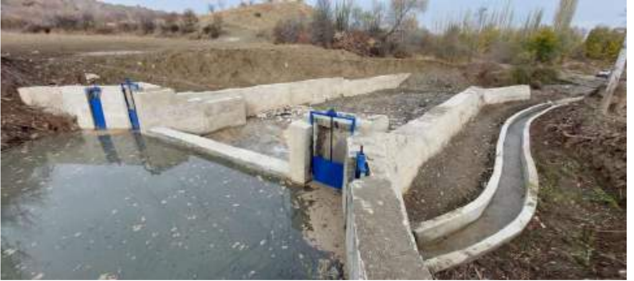
ÇORUM MERKEZ İNALÖZÜ KÖYÜ YERÜSTÜ SULAMA TESİSİ
