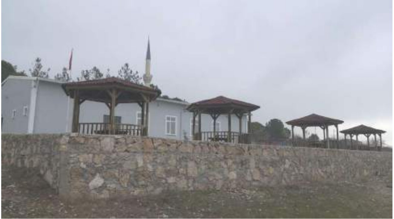
KAMERİYE YAPIM İŞİ
