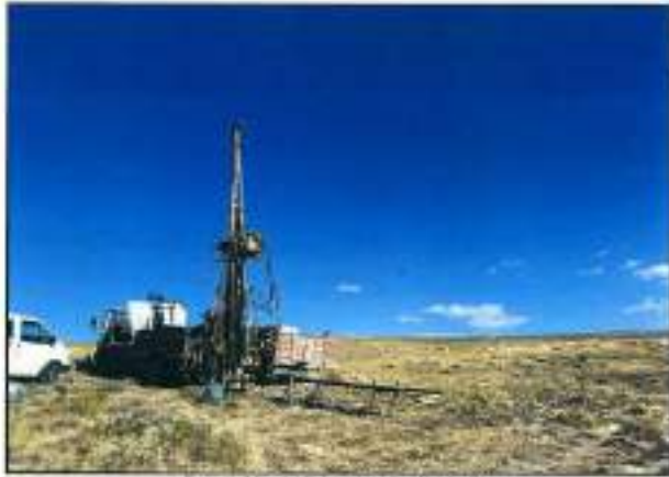
Resim 4.1: Jeolojik Jeoteknik Etüt Çalışmaları
